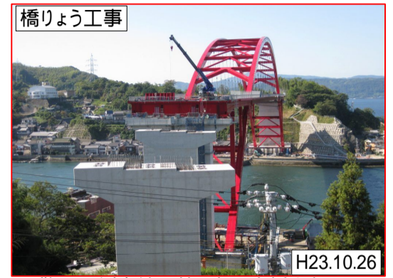
警固屋側本線～第2音戸大橋上部工
