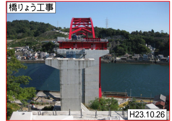
音戸側本線～第2音戸大橋上部工
