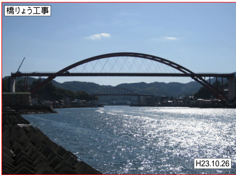
(仮称)第2音戸大橋上部工
