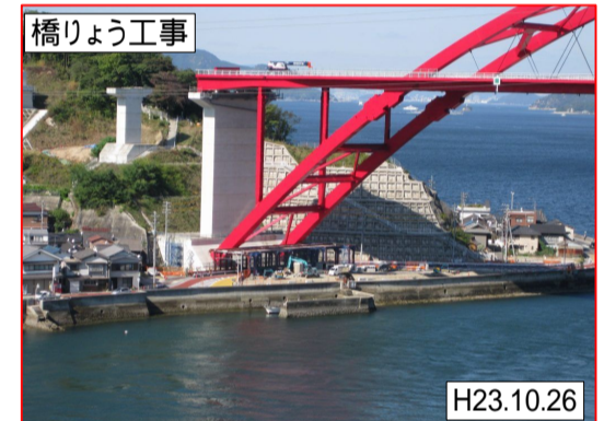
音戸側(橋りょうによる現道切替)
