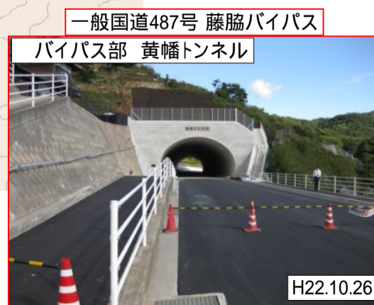
藤脇(黄幡トンネル抗口付近)
