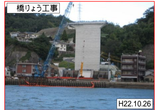
第2音戸大橋 警固屋側下部工
