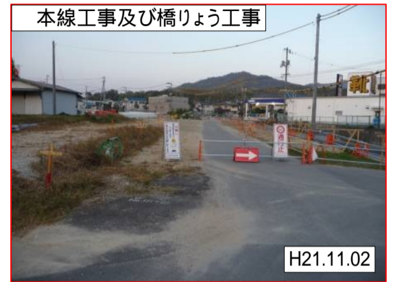
3号橋～4号橋付近
