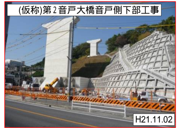
音戸側下部工
