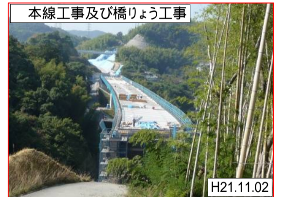
音戸側(坪井地区及び坪井大橋付近)
