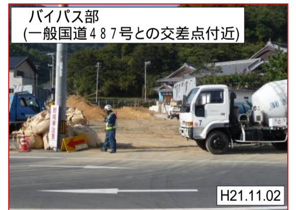
藤脇 一般国道487号との交差点付近
