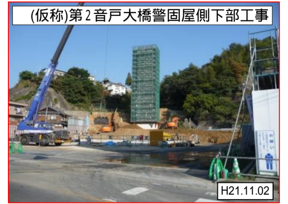
警固屋側下部工
