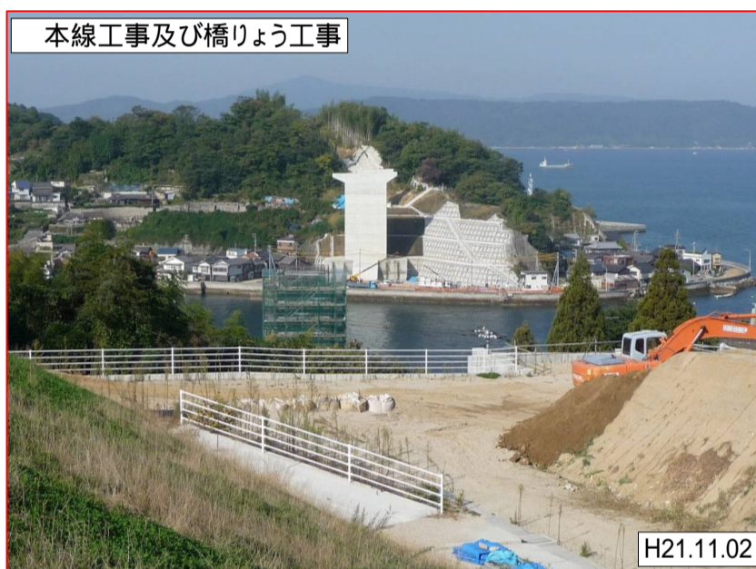
警固屋側(貴船神社付近)～(仮称)第2音戸大橋音戸側下部工
