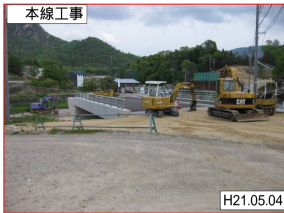
長谷川 橋りょう工付近
