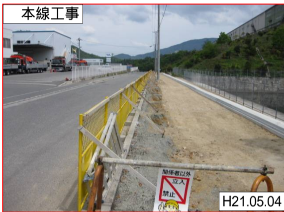
郷原工業団地付近
