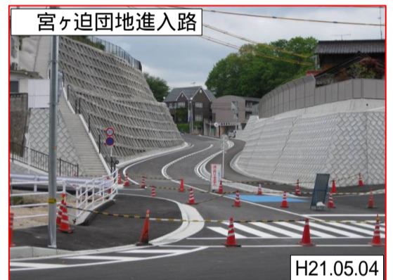
呉環状線接続部
