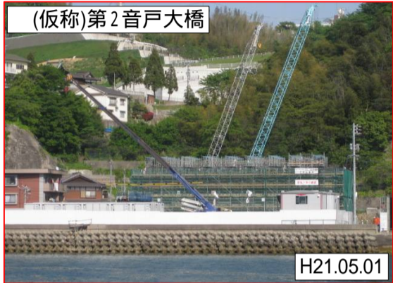
警固屋側下部工
