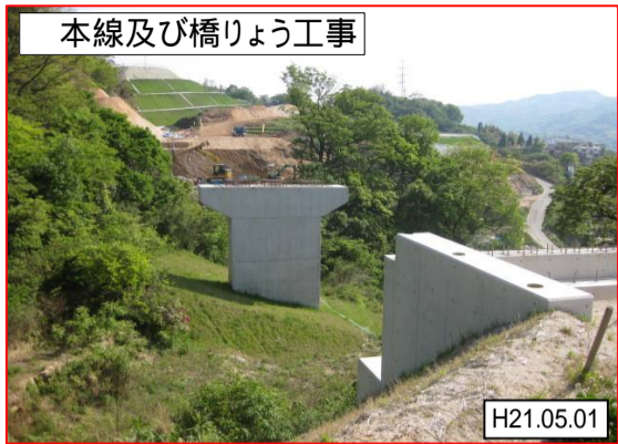
警固屋側(棚田川橋りょう部)
